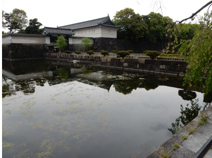
大手門（御城入口御門）
